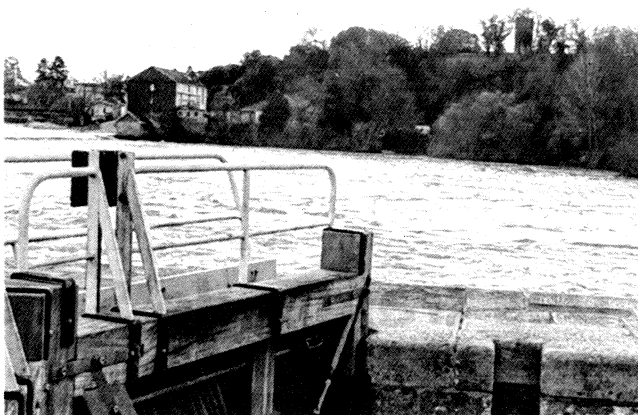
La chaussée des Moines, avec sa particularité : l'écluse.
